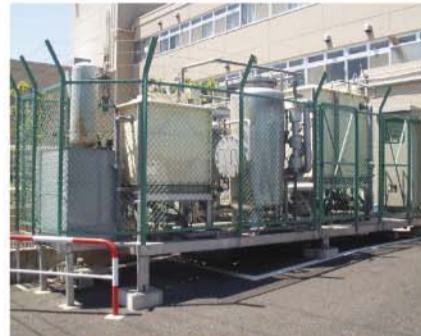
▲「地下水膜ろ過システム」の施工事例
