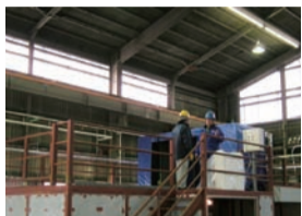
▲JR郡山車両基地での作業風景
