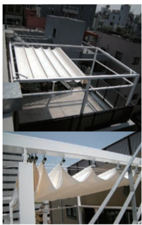
▲神楽坂ビル屋上 / カーテンレール式自動開閉テント
