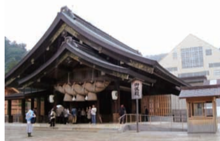
▲「出雲大社」の仮殿(後ろは修造中の本殿)
