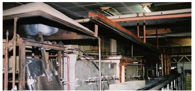
▲第一工場に設置された全自動プッシュ式連続電気炉。まず第1炉(600℃)で不燃物を燃焼し、第2炉(1100℃)で金属の粉末を結合(合金)させる。いわば2度焼きの工程は、除冷装置(空冷)を含めると約5時間にも及ぶ
